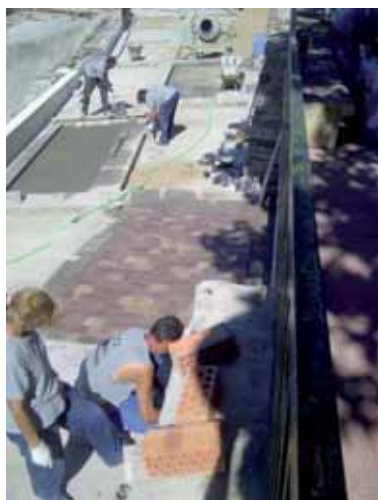
9.- Adoquinado con adoquín de Páramo Románico
