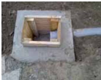
2.- Saneamiento, arquetas y sumideros, alcorque de nueva creación y plantación de nuevas especies vegetales con riego por goteo
