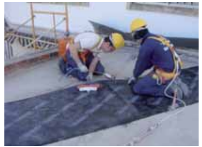
6.- Otros trabajos como la reparación de la terraza del hogar del jubilado para la eliminación de humedades
