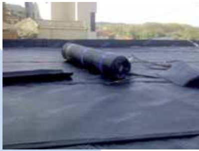
6.- Otros trabajos como la reparación de la terraza del hogar del jubilado para la eliminación de humedades
