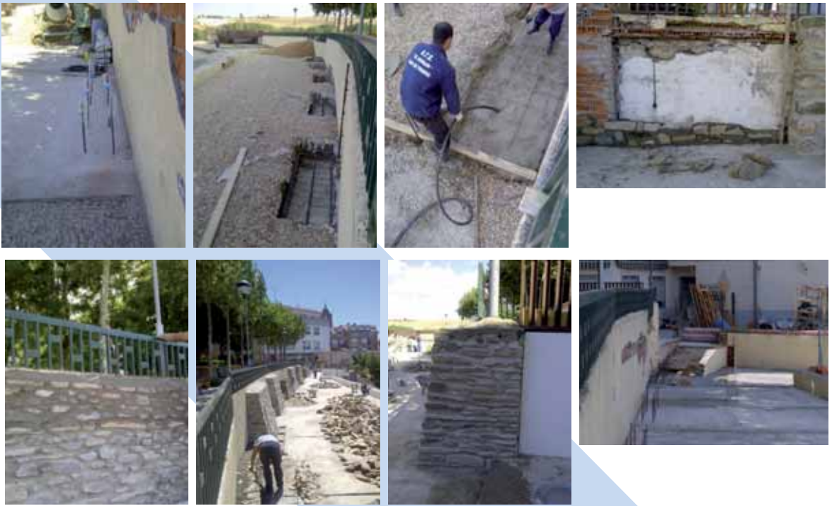
3.- Creación de contrafuertes para la sujeción del muro existente
