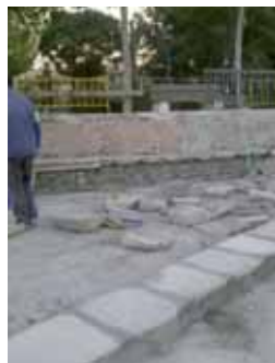
7.- Chapado de muros con pizarra.
