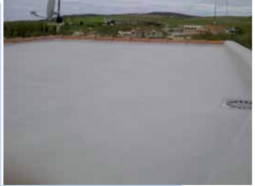
6.- Otros trabajos como la reparación de la terraza del hogar del jubilado para la eliminación de humedades
