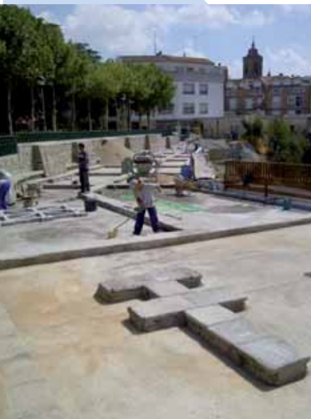
7.- Chapado de muros con pizarra.
