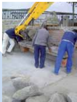
7.- Chapado de muros con pizarra.
