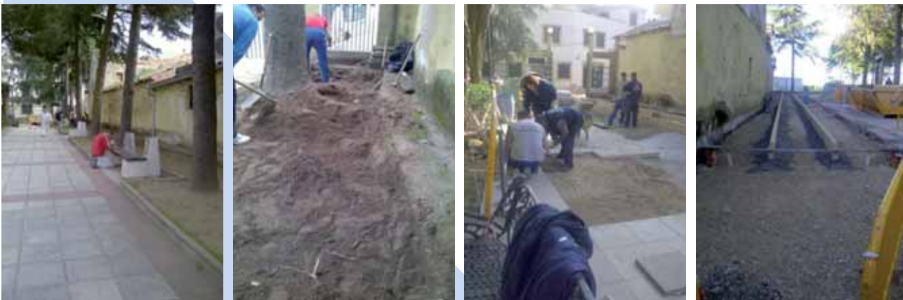
1.- Retirada de parterres, desplazamiento de bancos, y reparación del solado del parque de El Espolón
