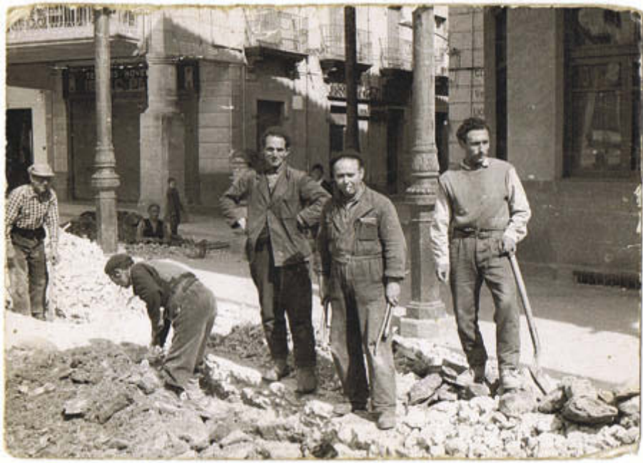
Felipe Pérez Jiménez (en el centro de la foto, metiendo las primeras tuberías de agua en la Plaza Mayor de Alba de Tormes)
