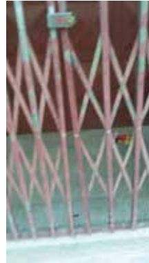
Antes de la intervención
