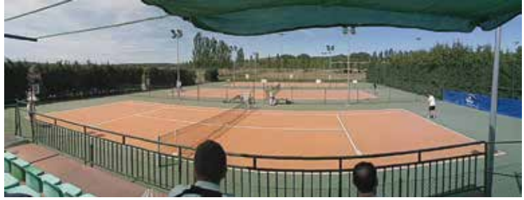
Pista de tenis reparada
