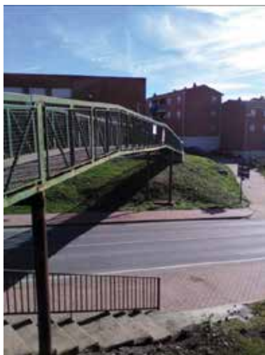
VISTA DE LA PASARELA ANTES DE LA ACTUACIÓN
